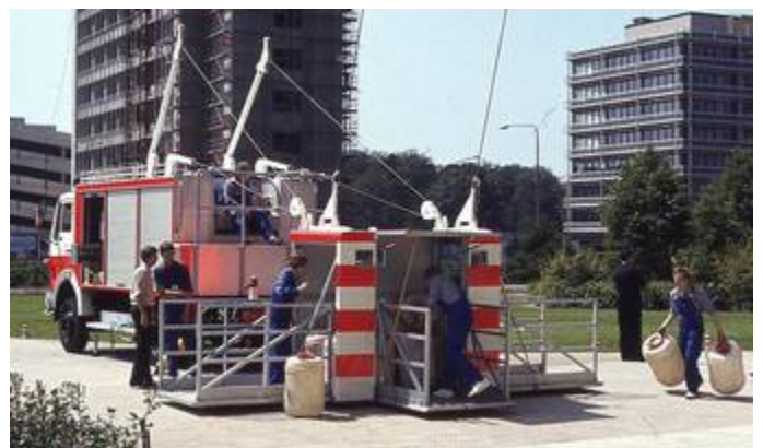
Erprobung des „Hochretters“ am Nestlé-Haus in der Bürostadt Frankfurt-Niederrad. Zunächst wurde die Rettungsgondel nur mit schweren Fässern anstelle von „Fahrgästen“ belastet
