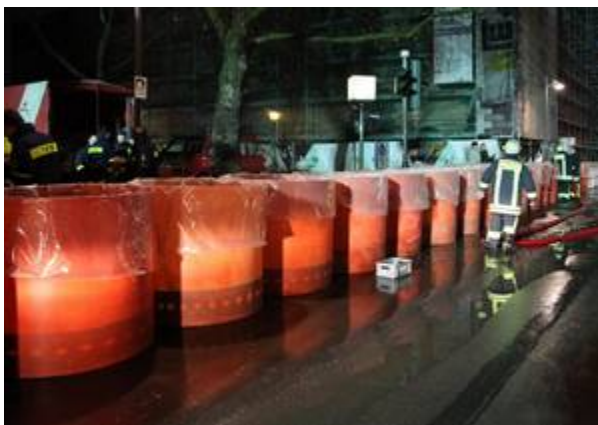
Aufbau der Aquariwa-Schutzlinie am Fahrtoer beim Main-Hochwasser im Januar 2011
