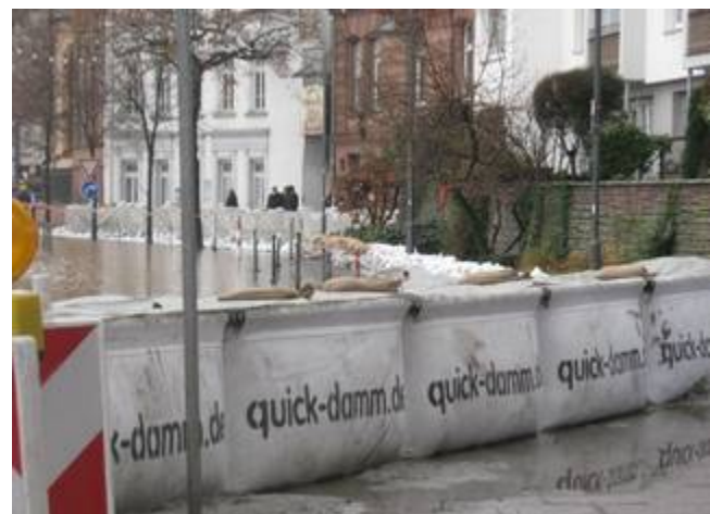
2011: Quickdamm-Linie im Bereich Leonhardstor
