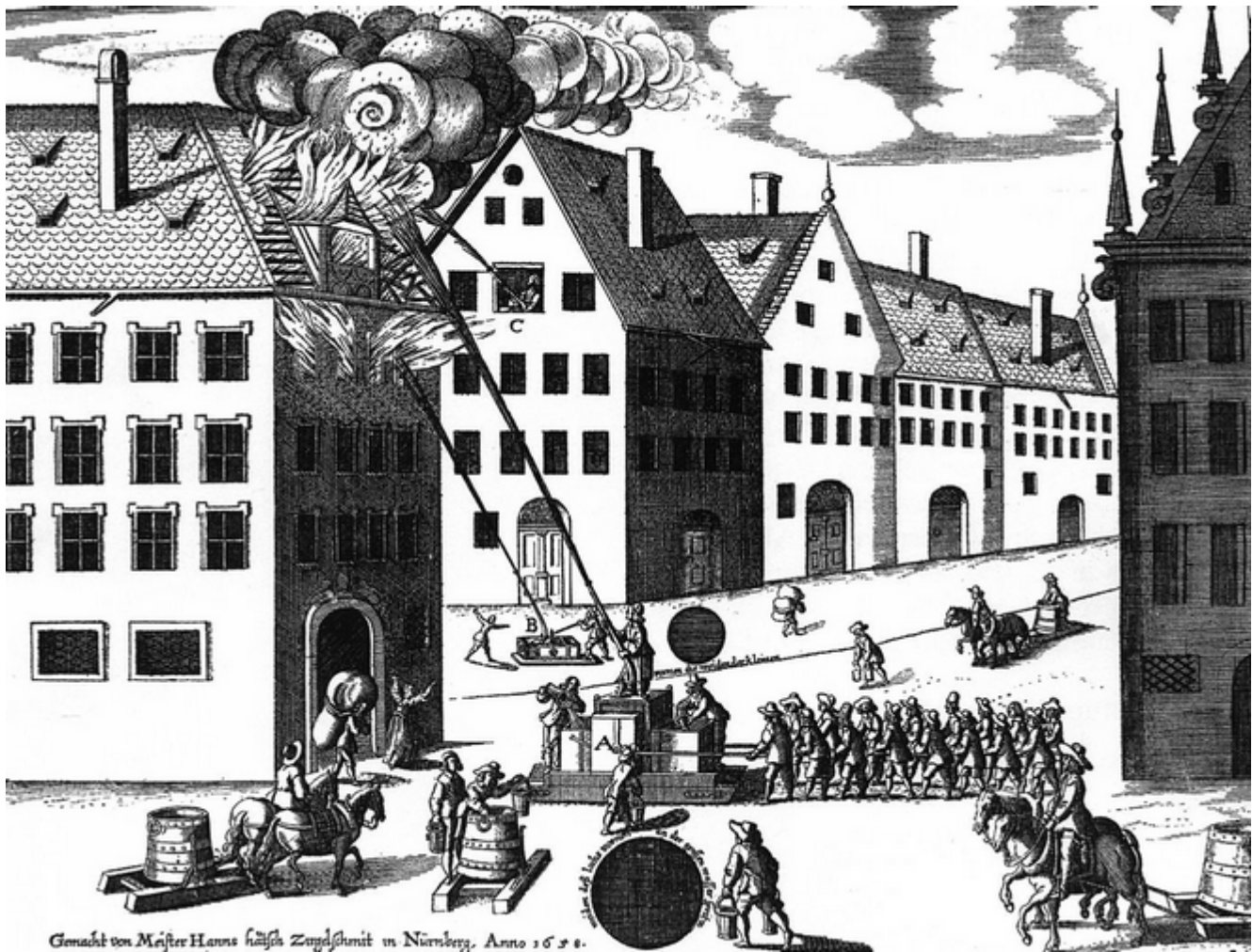
Nürnberger Feuerspritze, anno 1658, Wasserversorgung mit Bütten auf „Schleifen“ (Schlitten)
