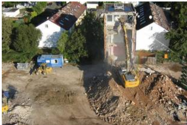
Abriss des ehemaligen Tauchturmes
