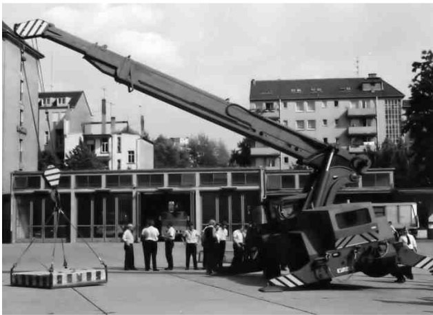
1976: Vorstellung des „Saturn“-Kranwagens der Fa. Hydrokran im Hof der Feuerwache 1
