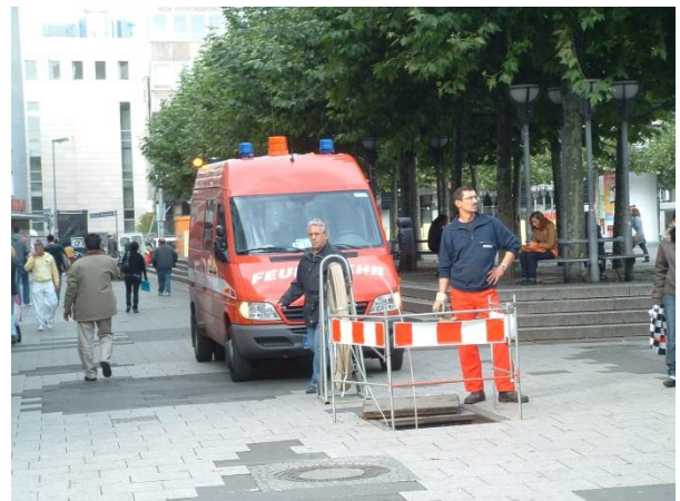
„Men at Work“: Kabeltruppe auf der Zeil
