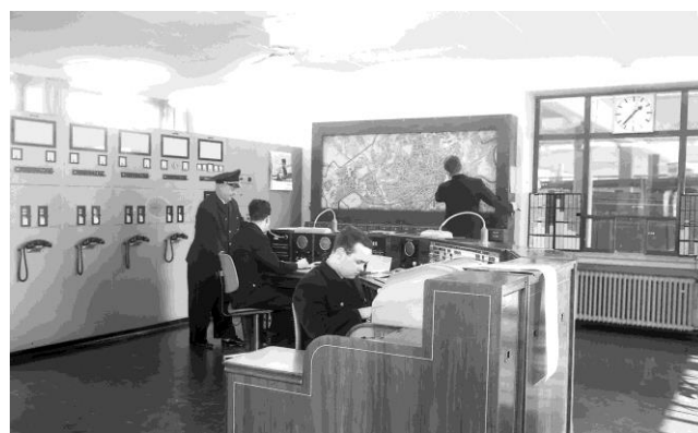
Leitstelle im Erdgeschoss der Feuerwache Hanauer Landstraße (späteres Wachbüro). Links hinten die Empfangseinrichtungen für die Feuermelder von T&N
