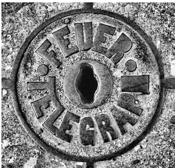
Revisionsdeckel eines Kabelschachtes des feuerwehreigenen Kabelnetzes; noch heute zu finden auf einen Fußweg in der Bockenheimer Kurfürstenstraße
