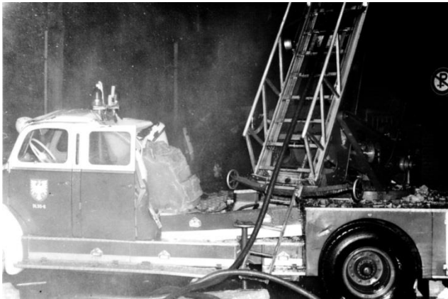
Von Trümmern zerstörte DL 30 im Innenhof
