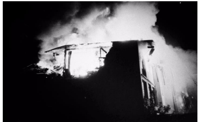
Stark zerstörtes Gebäude im Vollbrand
