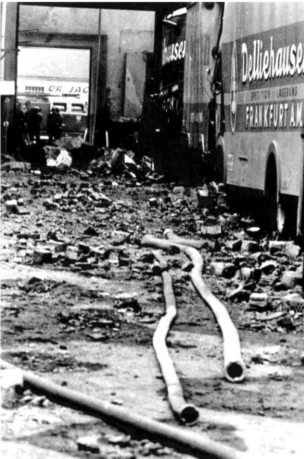
Eine der Durchfahrten nach ersten Aufräumarbeiten
