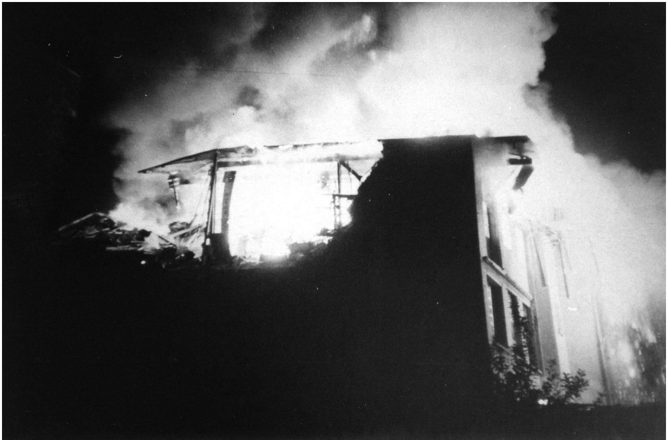
Das Lagerhaus der Firma Delliehausen nach der Explosion
