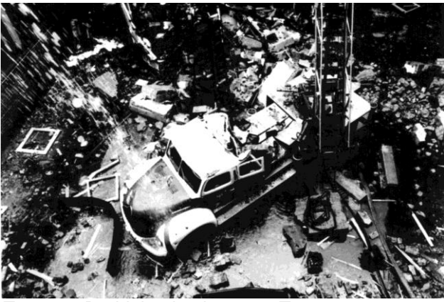
Zerstörte Drehleiter inmitten von Trümmern
