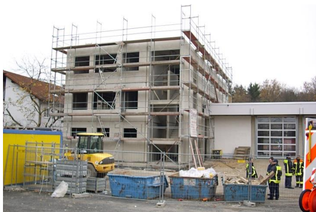
BF besichtigt Baustelle, Winter 2008/2009
