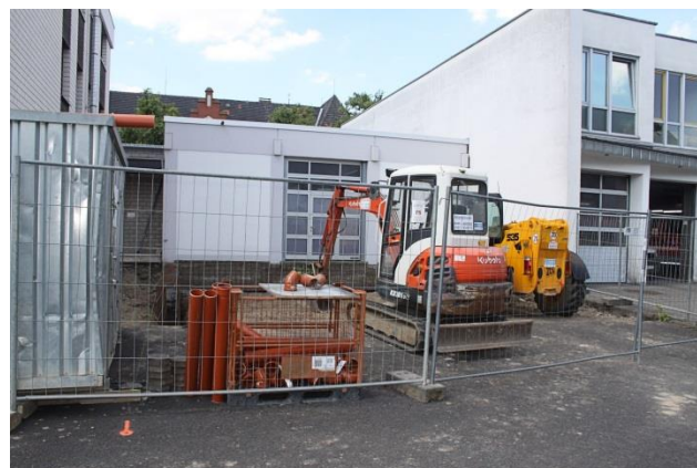
Juli 2016: Die Umbauarbeiten am Gerätehaus haben begonnen.
