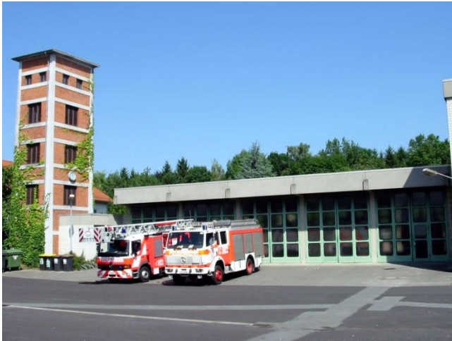
Das Enkheimer Gerätehaus im Jahr 2006 von der Hofseite aus gesehen. Der Schlauchturm und zwei Fahrzeughallen sollen für einen Neubau der Berufsfeuerwehr fallen.
