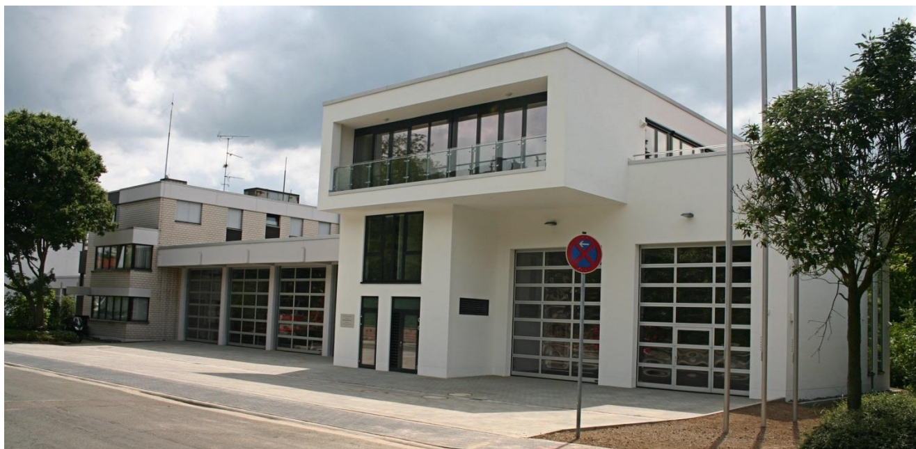
Bezugsfertige Feuerwache 11 (rechts) und umgebautes Gerätehaus (links) im Sommer 2009
