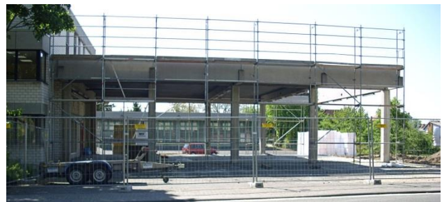
Im Sommer 2008 sind die Abrissarbeiten beendet und der Neu-Ausbau der Fahrzeughalle der FF beginnt. Rechts hat der Bau der Feuerwache noch nicht begonnen, da es Schwierigkeiten mit dem Untergrund gibt
