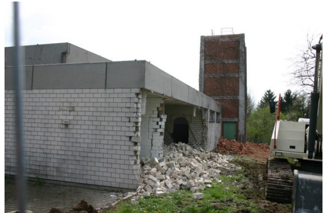
Abrissarbeiten, April 2008. Blick vom Florianweg in Blickachse mit der rechten Grundstücksgrenze
