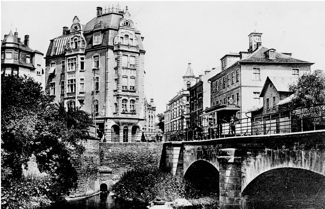
Niddabrücke in Rödelheim mit Feuerwehrrätehaus
