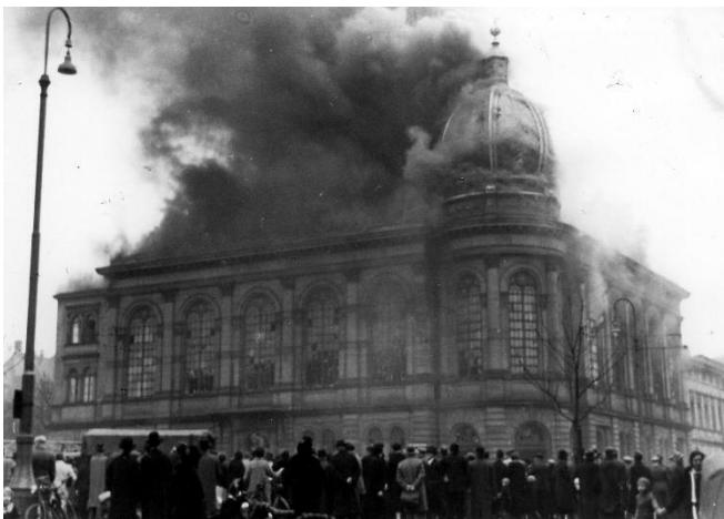
Abb. 22: Brennende Synagoge am Börneplatz. Die starke Rauchentwicklung aus Dach und Fenstern deutet auf die bevorstehende Durchzündung hin
