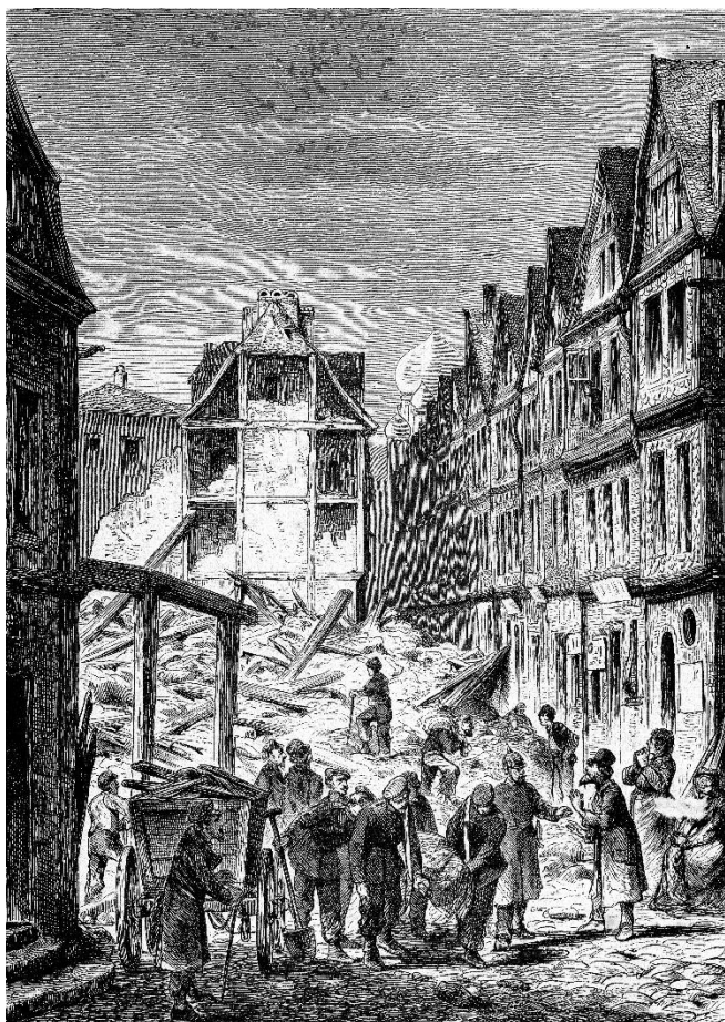
Abb. 4: Einsturz eines Gebäudes in der verfallenden Judengasse am 1. März 1872
