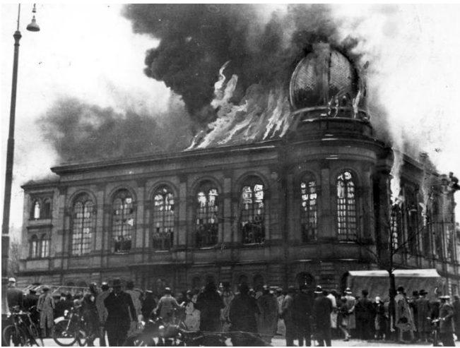
Abb. 24: Durch das durchgebrannte Dach und geplatze Fensterscheiben erhält der Brand nun auch ausreichend Sauerstoff. Hinter allen Fenstern sind nun helle Flammen erkennbar; die Synagoge steht im Vollbrand
