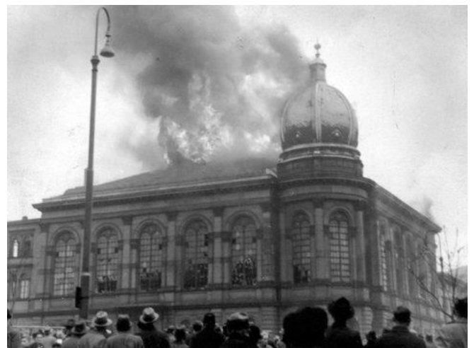
Abb. 23: Die Durchzündung ist erfolgt, Flammen schlagen aus dem Dach. Auf den Fotos ist am linken Bildrand eine Drehleiter zu erkennen, die aber nicht in Tätigkeit gesetzt wird
