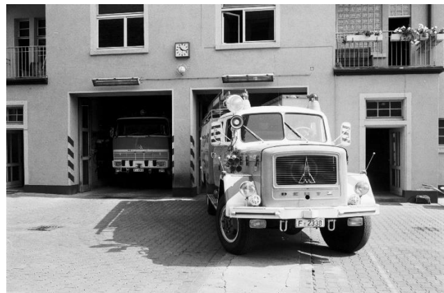
Wo ab 1914 die Automobilspritze und die wasserhydraulische Drehleiter standen, müssen nun moderne Großfahrzeuge untergebracht werden: HLF und TROWA in der Fahrzeughalle im Wachgebäude (hier heute Rettungswache)
