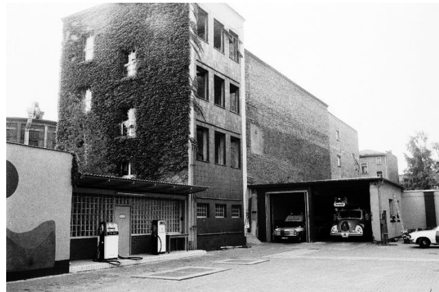
Allen immer wieder erfolgten Umbauten und Erweiterungen zum Trotz bleiben die Raumverhältnisse in Bockenheim prekär. Drehleiter und KTW stehen in einem Anbau im Hof
