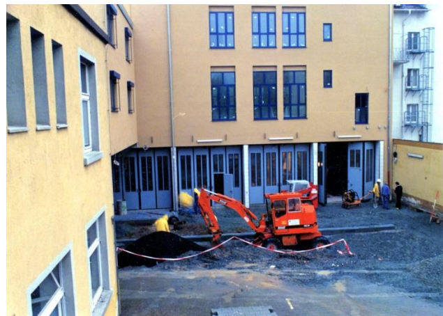
Kurz vor der Fertigstellung: Blick vom Balkon des Altbauwerks hin zum Neubau. Links unter dem Überbau befindet sich die neue Hofzufahrt mit Rolltor
