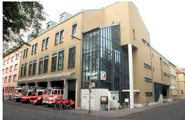
Fertiger Neubau: Blick vom Kurfürstenplatz auf die Straßenecke, wo einstmal das Bockenheimer Rathaus stand. Links die Fahrzeughallen mit GTLF, Z-RTW, Drehleiter, HLF und den beiden Motorrädern der Kradstaffel
