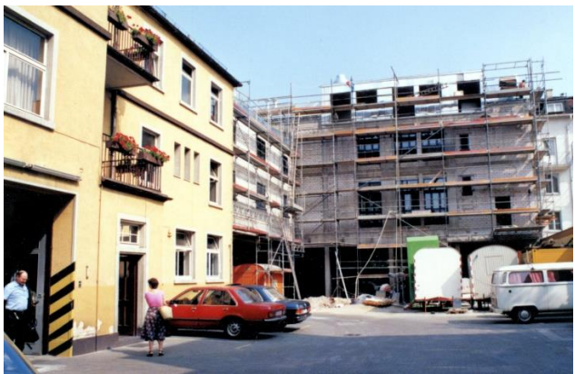
Bauphase: Blick vom alten Wachbereich in Richtung Kurfürstenplatz, wo bislang die Hofausfahrt der war und nun der Neubau entsteht
