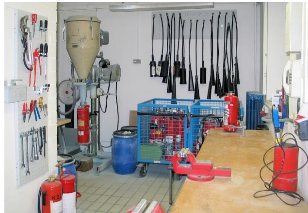
Die neue Feuerlöscherwerkstatt
