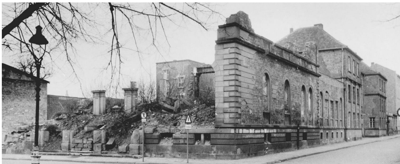
Straßenecke Kurfürstenplatz / Schwälmer Straße nach dem Krieg. Die Feuerwache ist notdürftig instandgesetzt, das Bockenheimer Rathaus ist völlig zerstört und wird später abgerissen.
