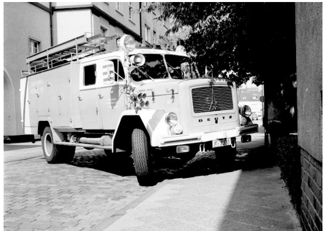
Die Ausfahrt der Großfahrzeuge in den Hof ist schwierig; zur Schwälmer Straße hin aber praktisch unmöglich, wie dieses Bild zeigt
