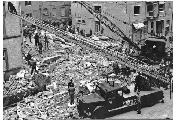
7.12.1955, Kölner Straße 14. Um das Haus links wurde ein Stahlseil mit Hilfe der DL von Wache 3 gezogen, es soll das Einstürzen der Brandmauer verhindern. Ein Autokran der US Army unterstützt die Bergungsarbeiten. Ein Teil der Trümmer ist bereits abtransportiert.
