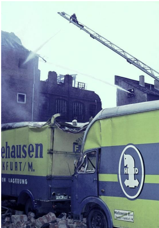
Über DL 30-7 und dem Treppenhaus Speyerer Straße 8 wird noch am Morgen danach Wasser gegeben. Foto: Helmut Anhäuser
