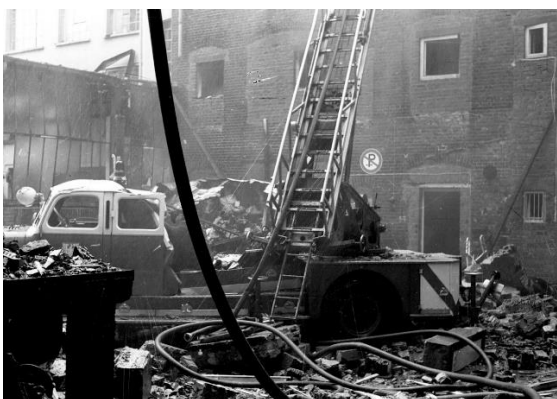
Zerstörte DL 30-6 von Zug 3 im Innenhof.
