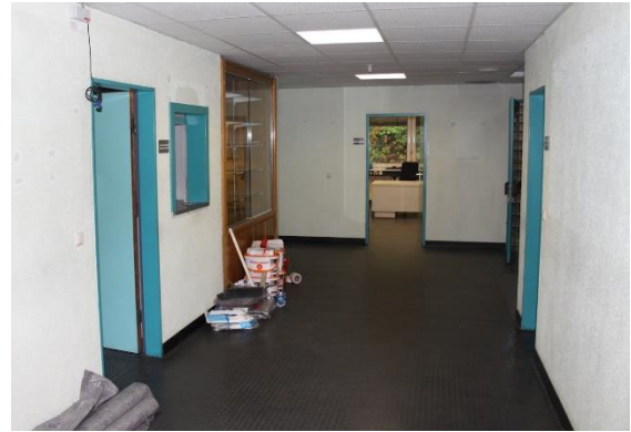
Die Farben sind bereitgestellt; die Arbeiten beginnen im Erdgeschoss
