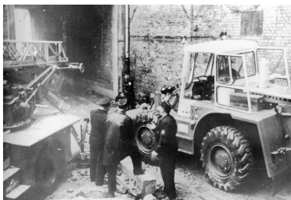
Der Radlader CAT beim Räumen der Durchfahrt
