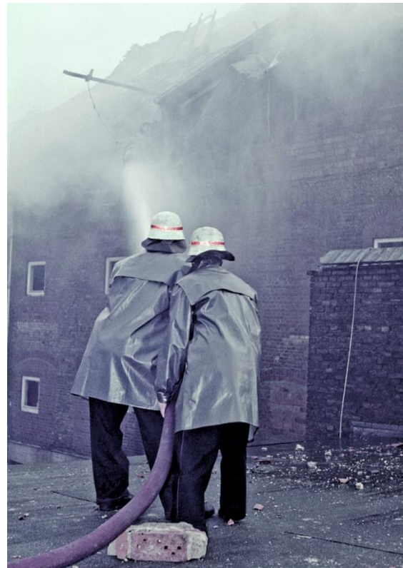
Vom Flachdach eines angrenzenden Gebäudes in der Frankenallee wird ein B-Rohr vorgenommen. Foto: Helmut Anhäuser
