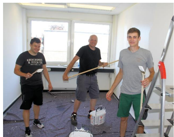
Unerwartete Hilfe: Sechs Kollegen der Feuerwache 11 kommen nach dem Dienst für einen Tag und streichen drei Räume komplett
